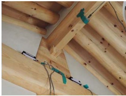
부엌 센서 설치
