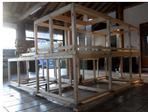
(f) 전체 골조 조립
