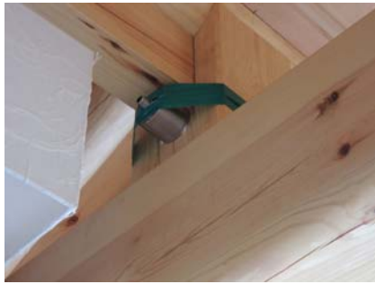
방 센서 설치
