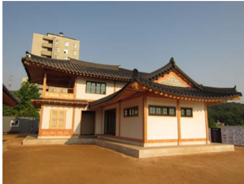
그림 4. 시공 및 성능 테스트동
